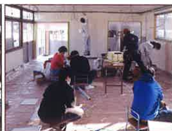
内装改修・電気工事
