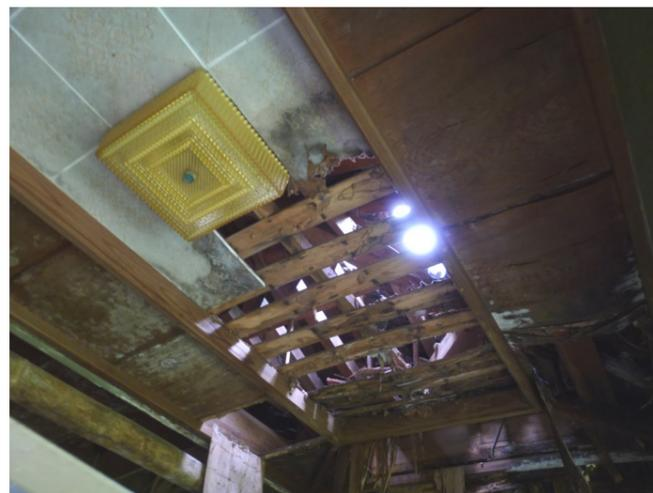
雨漏りのため、1階にもかかわらず外光が差し込む様子
