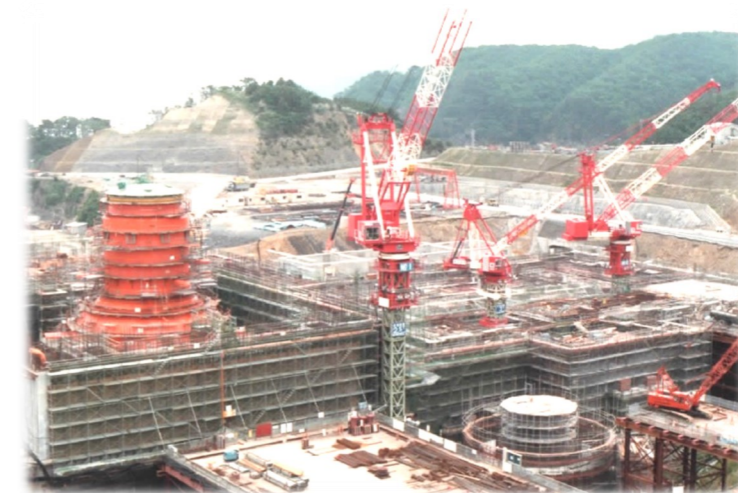
建設中の女川原発1号機 (宮城県女川町 1981年ごろ)
