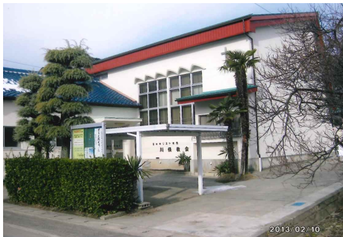
2013年 補修後の川俣教会外観
